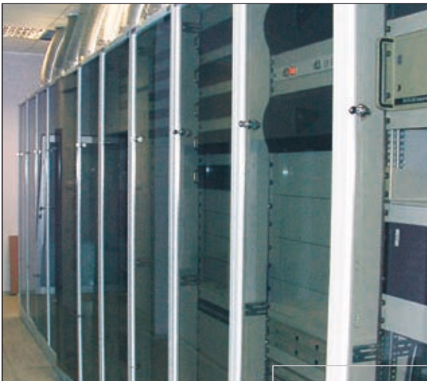
Шкафы телекоммуникационные и серверные производства ZPAS установлены в серверных помещениях „Цифрового Польсата” в Варшаве ( www.cyfrowypolsat.pl )
