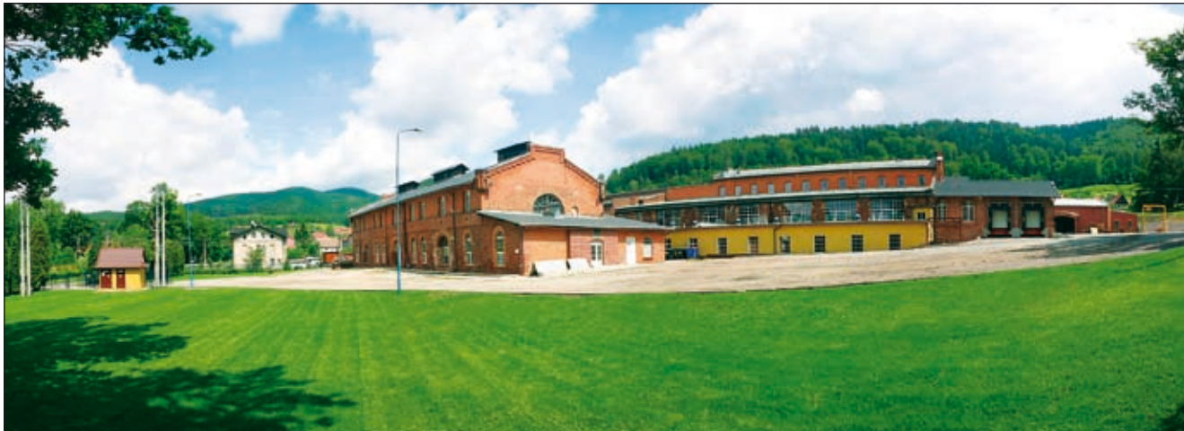
Производственный цех завода ZPAS в Пшигуже (Przygórze)
