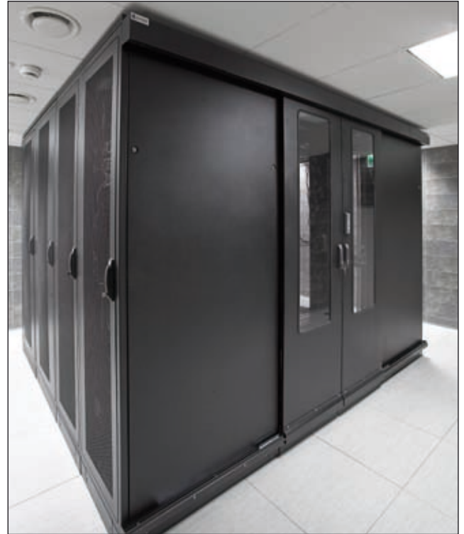
Серверный бокс, производства ZPAS, установлен в компании Volkswagen Motor Polska Sp. z o.o. в Польковицах
