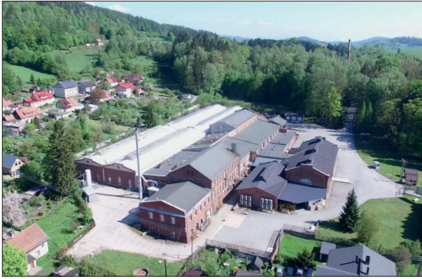
Przygórze Vorstandsbüro ZPAS S.A., Verwaltung und Projektspezifische Produktion
