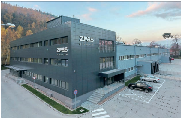
Nowa Ruda – Drogosław, Piłsudskiego Str. Fertigungsstandort – Elektrische Montage
