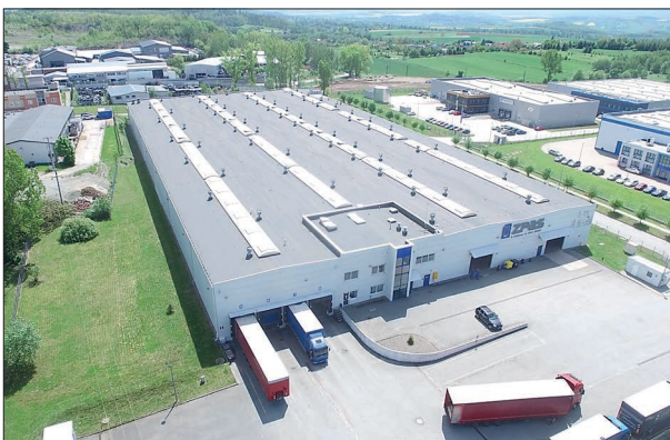
Nowa Ruda – Słupiec, Spacerowa Str. Serienfertigung und Lager für Fertigprodukte
