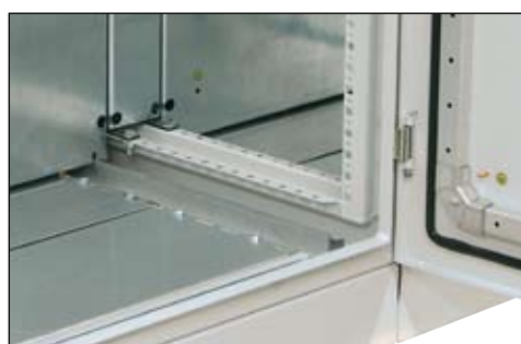
Sposób łączenia szeregowego szaf z zastosowaniem łącznika płyt montażowych
