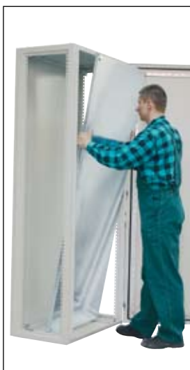
Sposób montażu płyty montażowej w szafie
