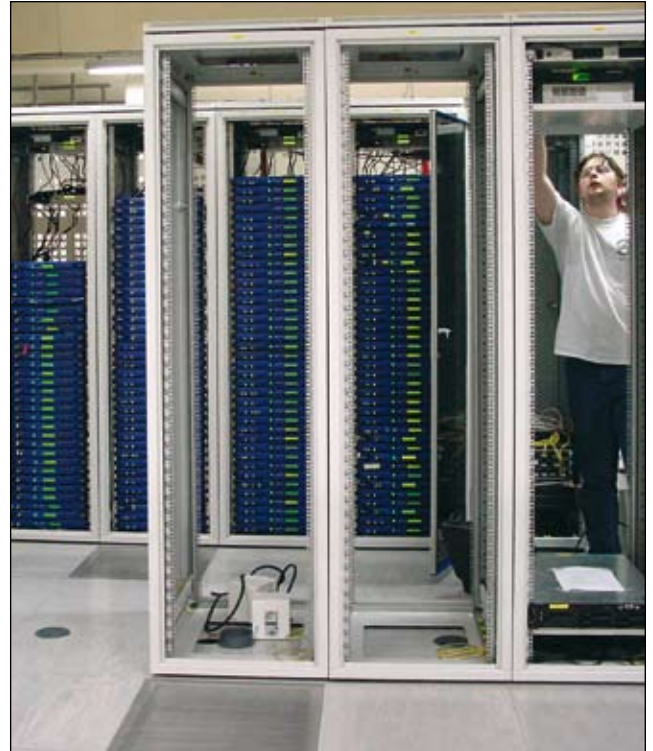
Montaż serwerów do szaf SZB w serwerowni internetowej firmy OVH w Paryżu
