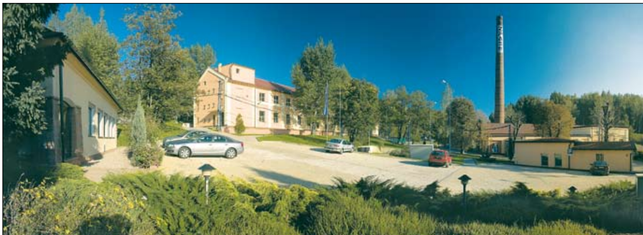
Górna część zakładu ZPAS w Przygórzu
