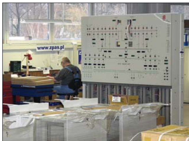
Montaż tablic mozaikowych
