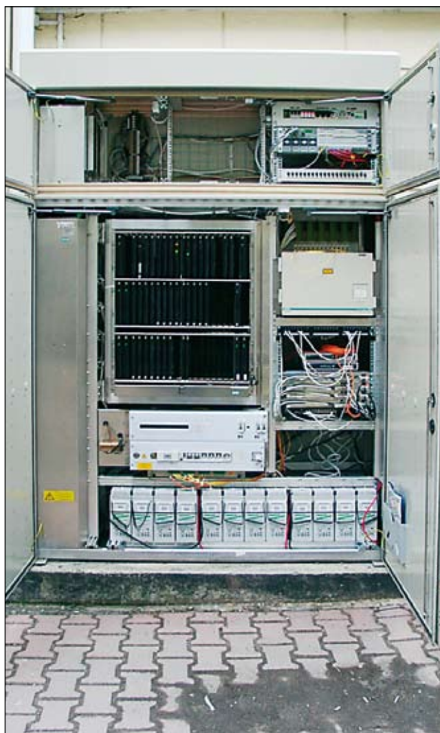
Szafa po rozbudowie
