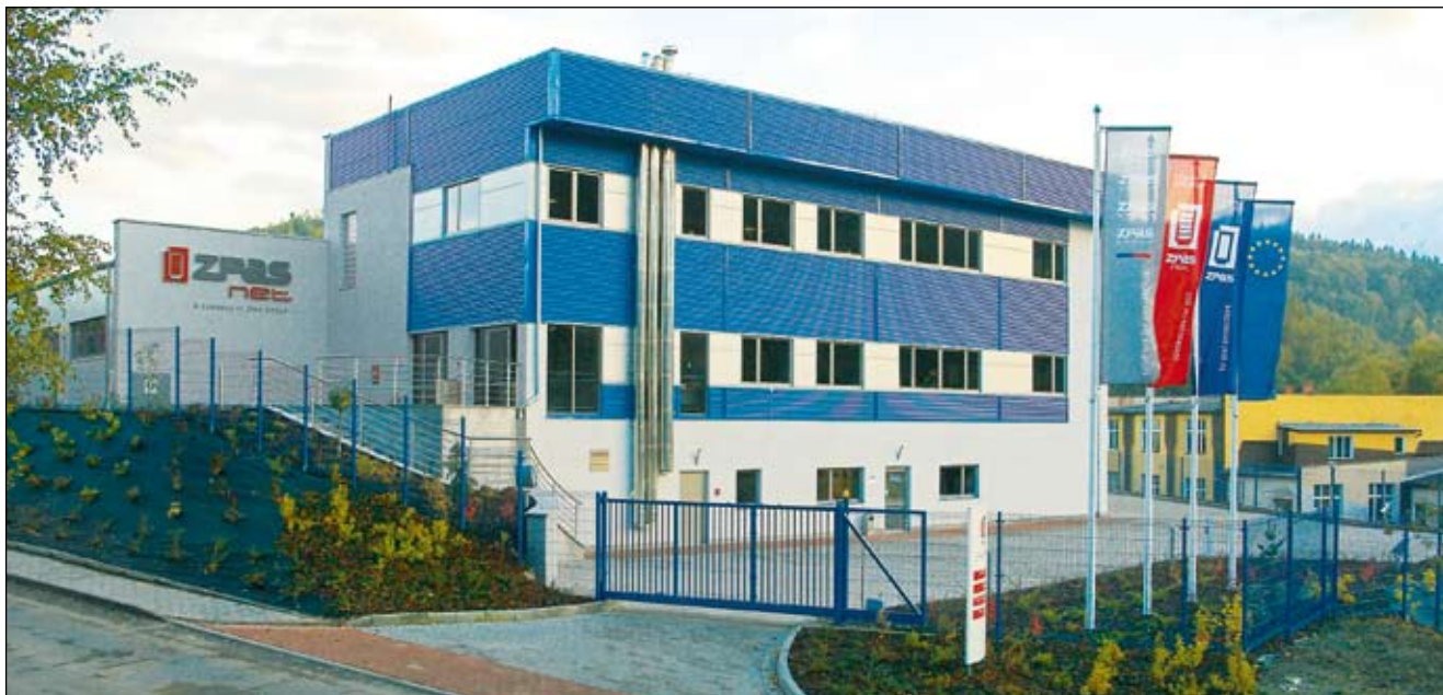
Budynek administracyjny ZPAS-NET
