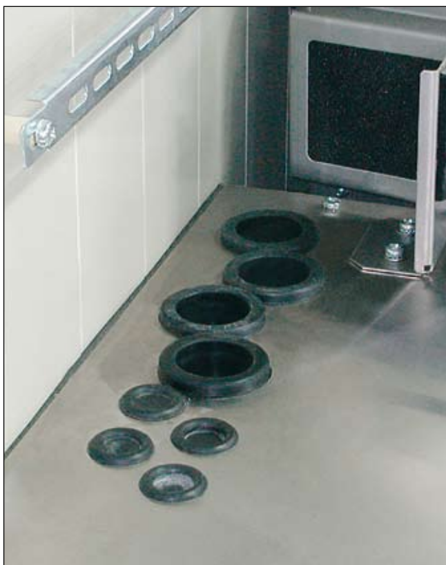
Przepust wykonany z dławików gumowych
