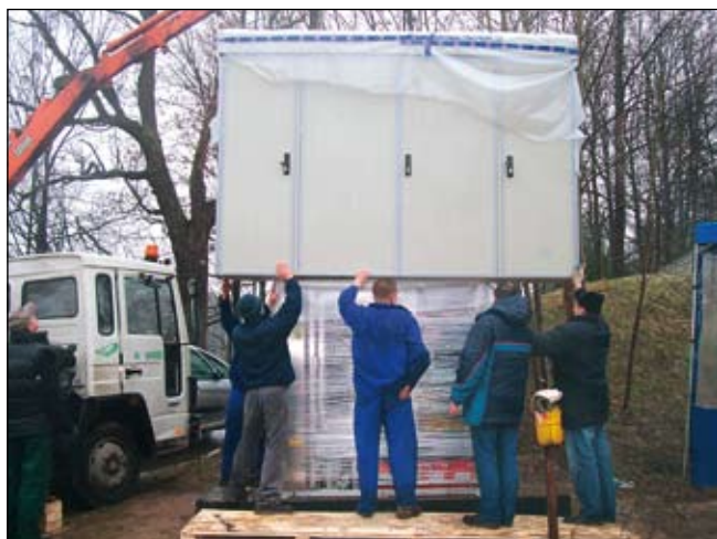
Szafa w trakcie rozbudowy
