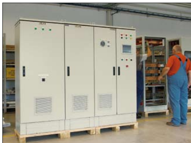
Montaż szaf energetycznych
