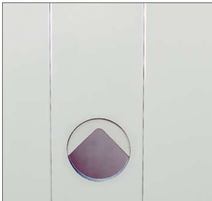
Wejście gniazda kablowego widoczne od strony zewnętrznej
