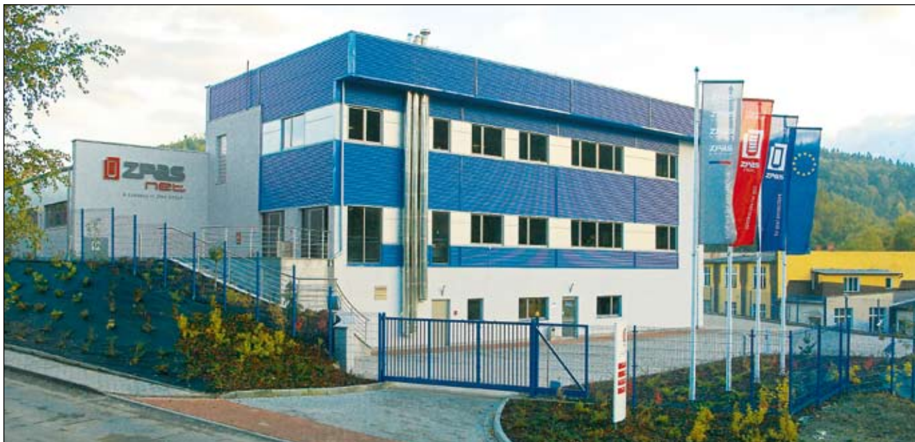
Budynek administracyjny ZPAS-NET
