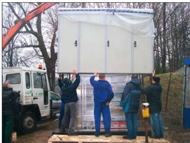
Szafa w trakcie rozbudowy
