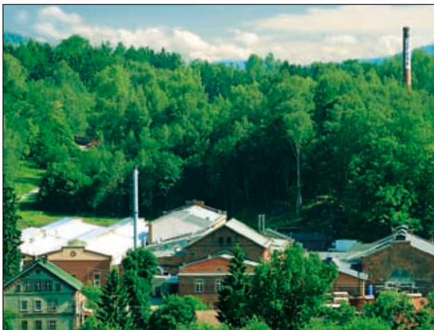
Sicht von oben auf das Produktionsgelände in Przygórze
