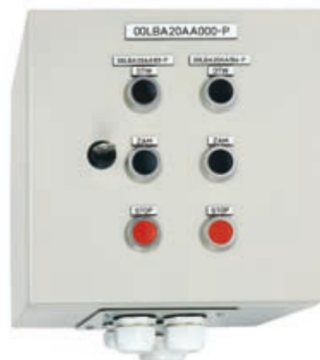
Boîte de commande pour la Centrale Électrique Bełchatów fabriquée sur la base de coffrets de type SWN
