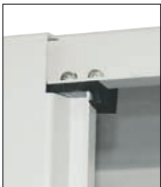
Способ уплотнения двустворчатой двери, обеспечивающий степень защиты IP 64
