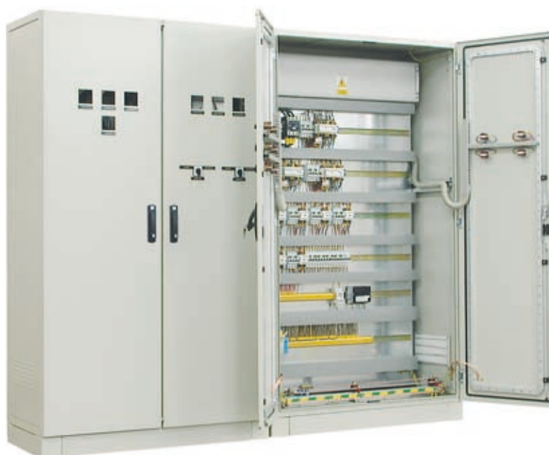
Распределительный щит низкого напряжения для цинкового завода Галесс в Свиднице
