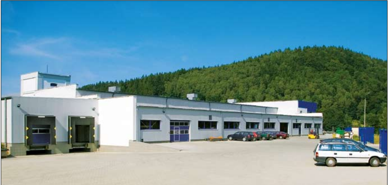
Die Produktionshalle der Firma ZPAS-NET
