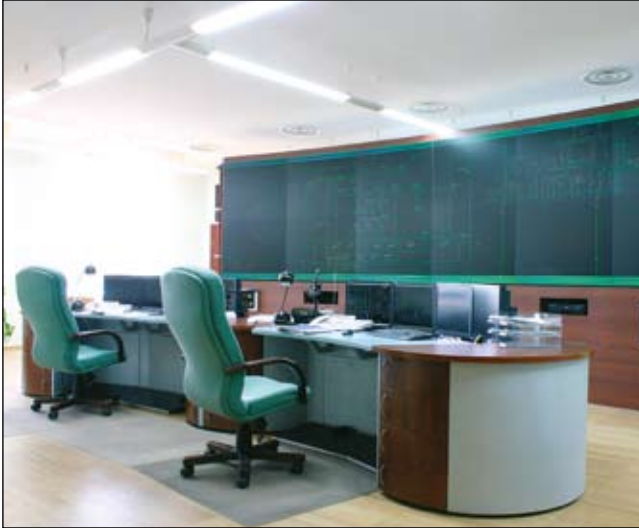
Modulpult PDM im MS-Distributionspunkt
