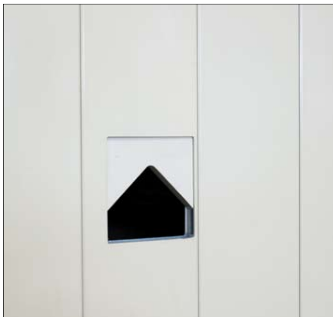
Wejście gniazda kablowego widoczne od strony zewnętrznej
