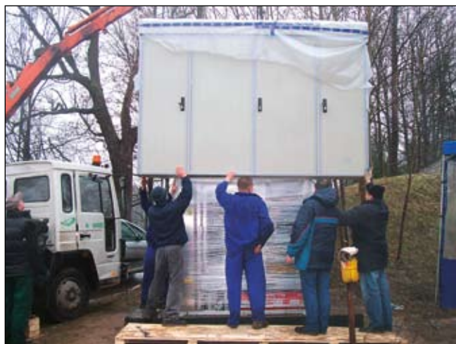
Шкаф в период реконструкции
