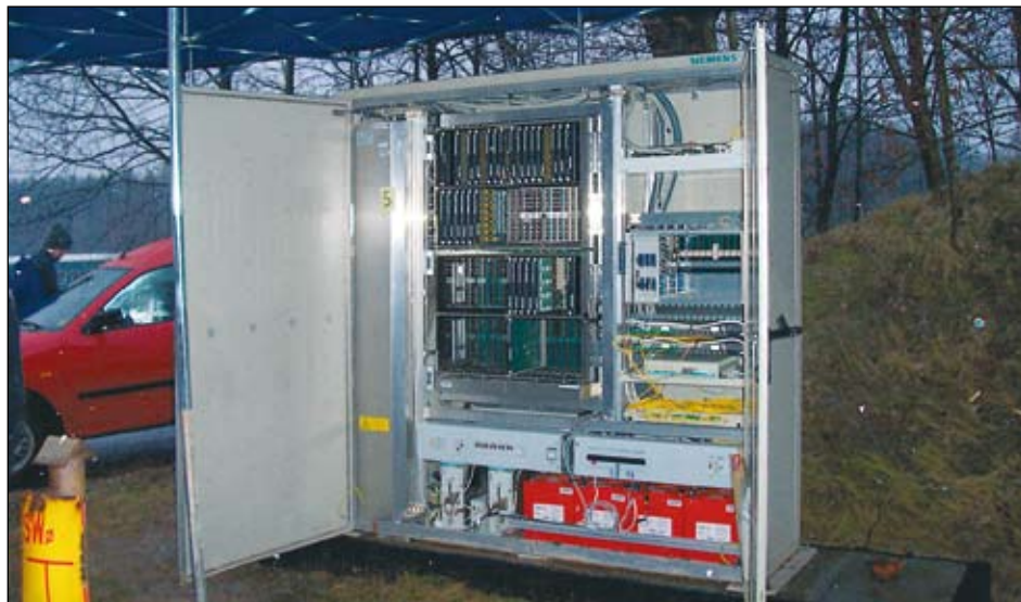
Шкаф перед реконструкцией
